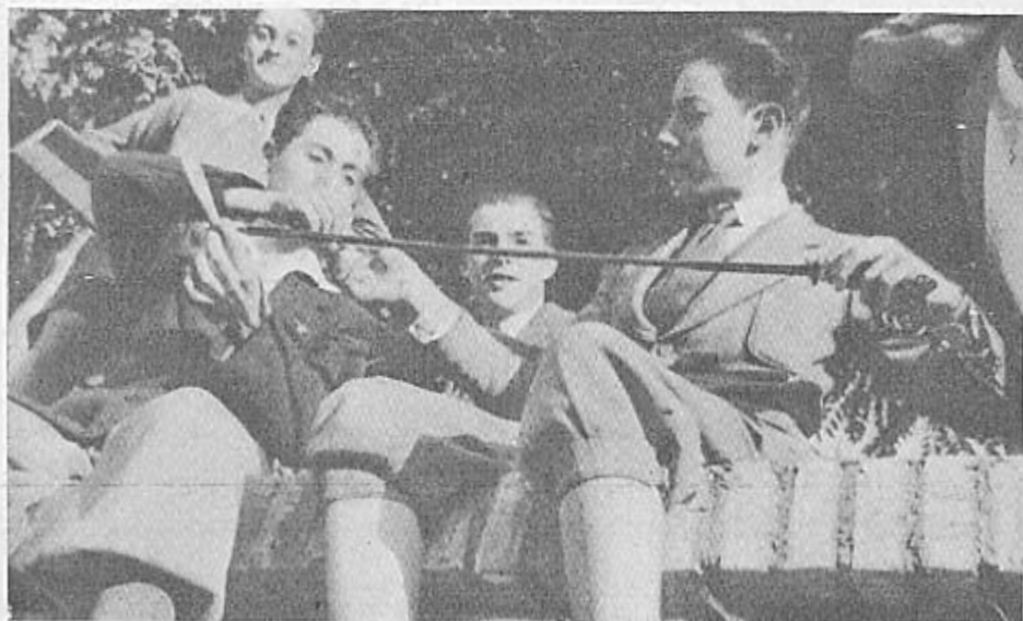
Prima di applicare la matassa elastica all'apparecchio gli aeromodellisti si assicurano che tutti i fili abbiano la medesima tensione.
